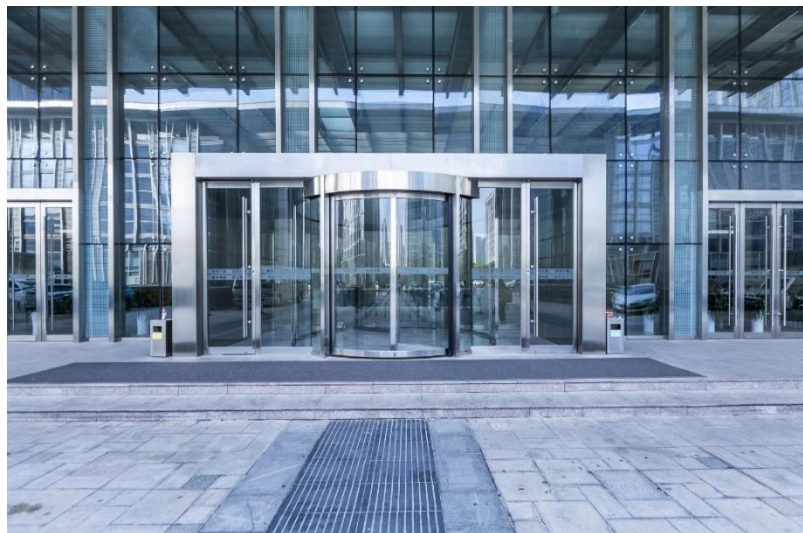
Abbildung 3: Dieser moderne Haupteingang ist nicht barrierefrei. Für sehbeeinträchtigte Personen ist es besonders schwierig, hier die Türen und Glaswände zu erkennen. Achten sie auf kontrastreiche Markierungen und das optische Hervorheben des Eingangs, etwa durch eine kontrastreich ausgeführte Umrandung. Adobe Stock ©MyCreative
