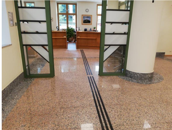
Abbildung 4: Taktile Bodenleitsysteme zur ersten besetzten Stelle sind eine wichtige bauliche Maßnahme, um die Barrierefreiheit im Gemeindeamt zu gewährleisten. Diese Orientierungshilfen sind für Menschen, die einen Blindenstock verwenden tastbar und können entlang dieser Linien sich fortbewegen. Auch Menschen mit Sehbeeinträchtigung nutzen diese, um sich zu orientieren.
